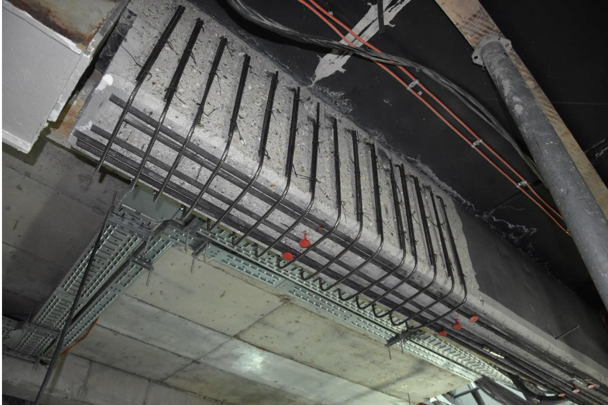
Verstärkung Biegezug sowie Schubverstärkung eines Trägers in Belgrad
