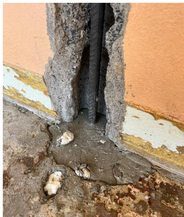
Ancrage avec mortier de re-bar dans la dalle en béton
