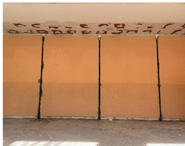
Rainures avec re-bar ancrées
