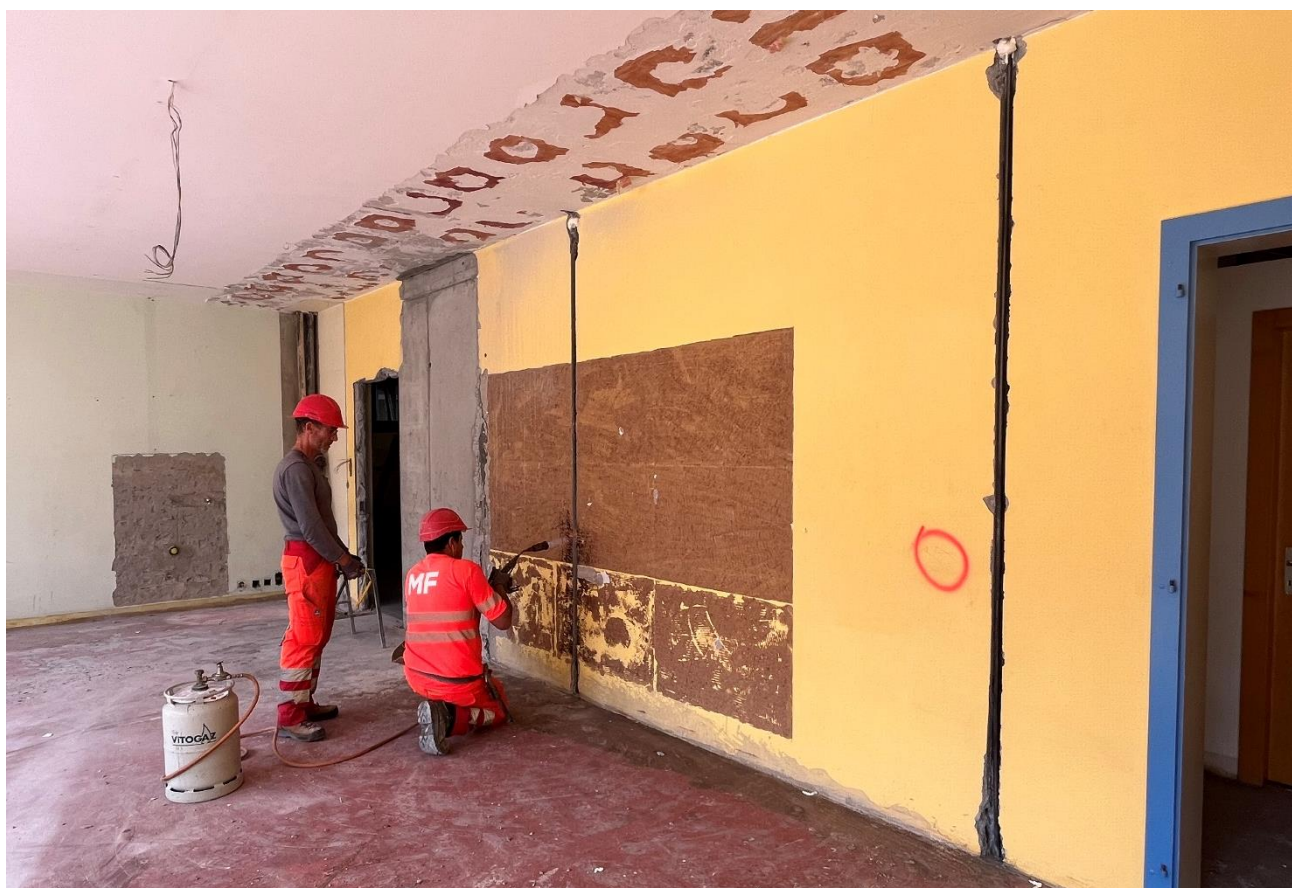
Chauffage des re-bar 16 ancrées
