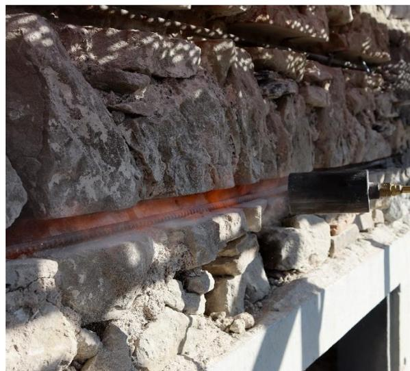
Activation de re-bar par chauffage au chalumeau
