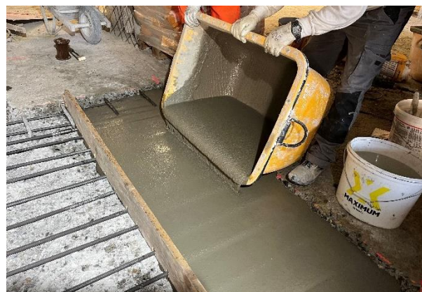
Scellement des zones d'ancrage
