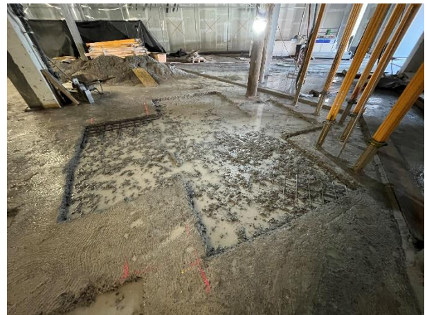
Zones de renforcement, élimination des débris
