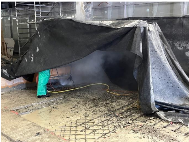
Enlèvement HDW des zones de renforcement
