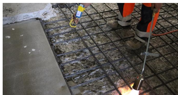
Activation de re-bar au chalumeau et contrôle de la température
