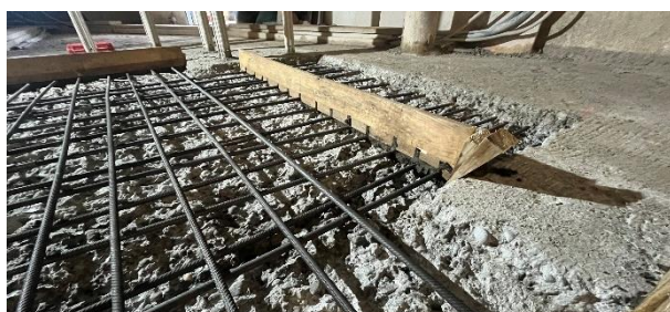
Lit de mortier et coffrage en bois
