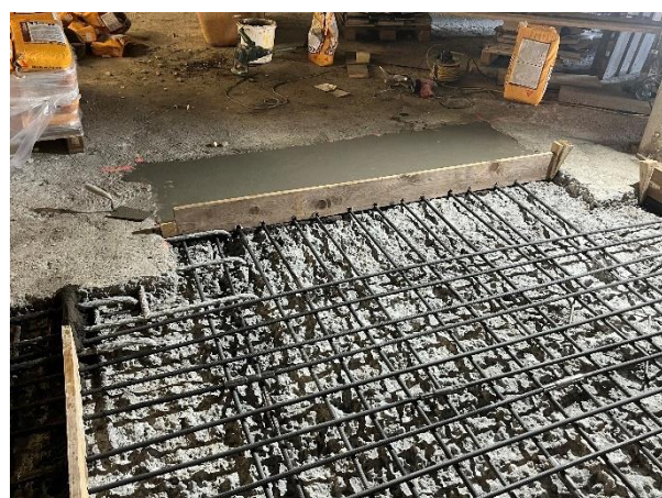
Ancrages avec SikaGrout®-314 N
