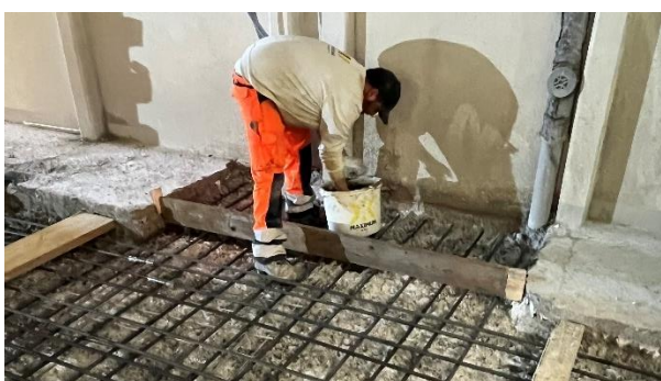
Préparation du coffrage
