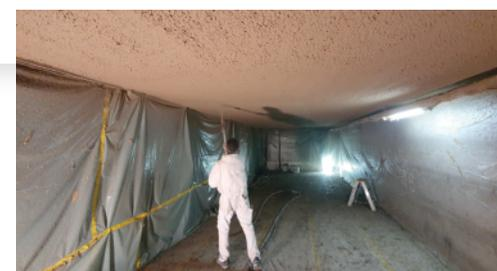
La protection contre le feu de re-plate est assurée par un simple enduit de protection contre le feu projeté Sika. L'acier atteint déjà un **R120** avec une épaisseur de couche de 25 mm.
