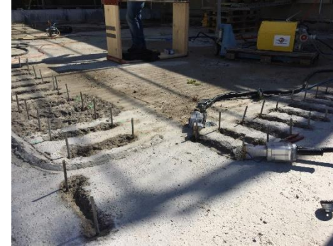
Aktivierung der memory-steel Bügel
