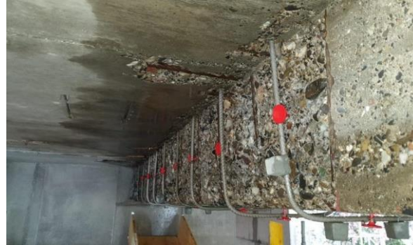
memory-steel Bügel für die Schubverstärkung
