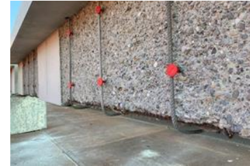
Montage der memory-steel Bügel
