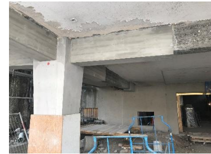
Aktivierung der memory-steel Bügel
