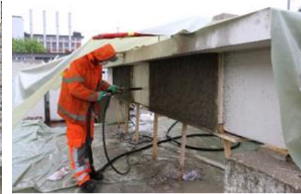
Spritzbeton (Sika Monotop)
