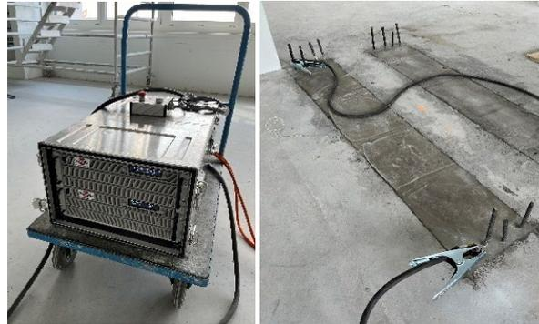
Appareil de chauffage par résistance électrique
