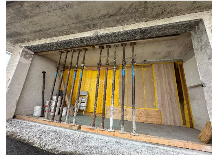
Fertig sandgestrahlt, mit Staubsauger nachreinigen
