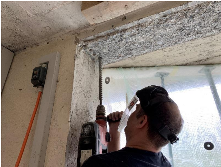
Bohrdurchmesser gem. Verarbeitungsrichtlinie, Tiefe projektspezifisch
