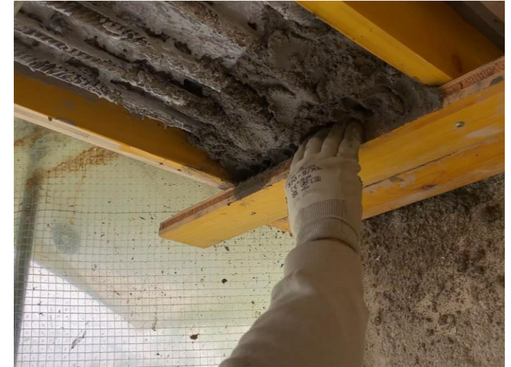
Schalung raufschrauben, Mörtel händisch unterstopfen bis eindeutiger Druckunterschied im Mörtel feststellbar
