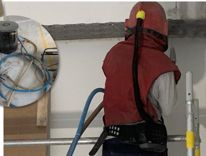
Sandstrahlen (Schutzbekleidung, Atemschutzmaske mit Akku-Luftzufuhr)
