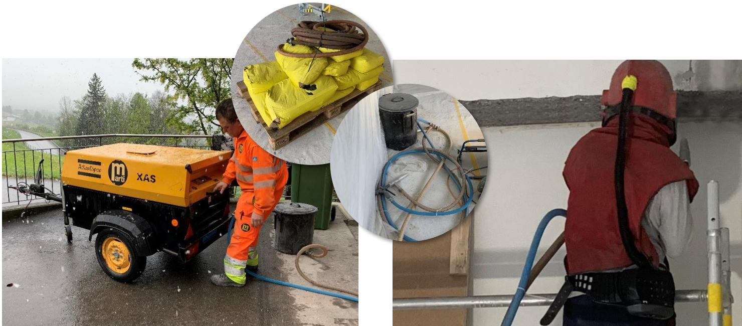
Kompressor, ca. 3-5 m 3 (hat Bauunternehmer), mobiles Strahlgerät und Strahlgut (hier: Korund)
