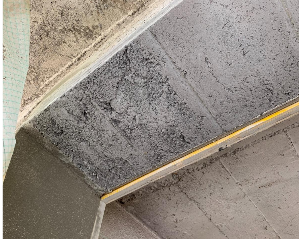
Hohlstellen nachträglich noch austreichen / Oberflächenfinish
