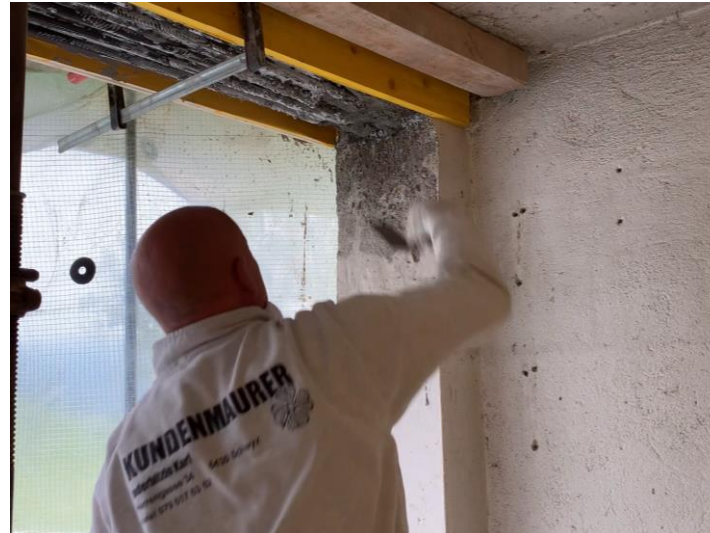
Händisches Anwerfen der ersten Mörtelschicht (Kellenwurf)
