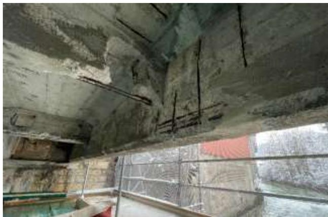
Enlèvement du béton endommagé
