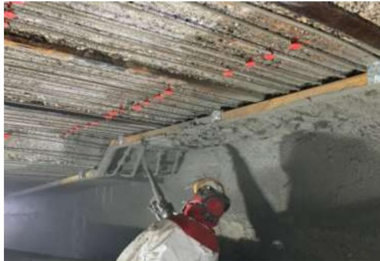
Fixation de re-bar, application du mortier projeté Sika® MonoTop® aux extrémités
