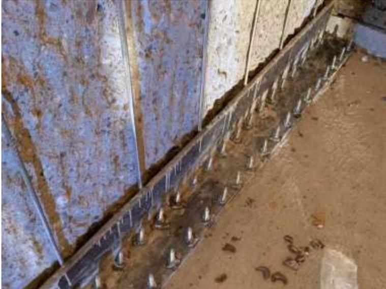
Introduction des forces dans la fondation par l'intermédiaire d'un profilé en acier (soudé)
