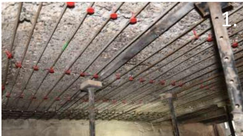
Substrato con una rugosità sufficiente, messa in opera delle re-bar
