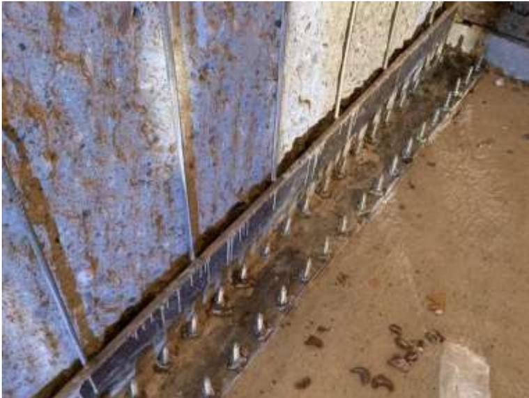
Distribuzione delle forze nella fondazione tramite un profilo in acciaio (saldato)
