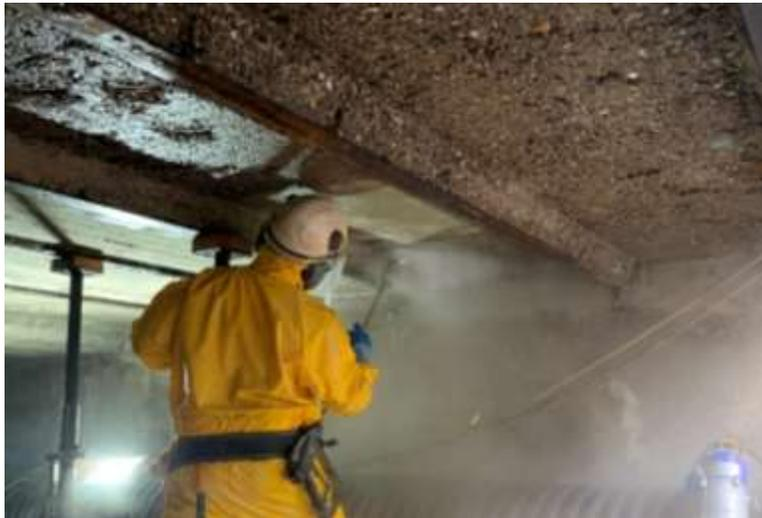
Irruvidimento della superficie e rimozione del calcestruzzo danneggiato mediante idrodemolizione
