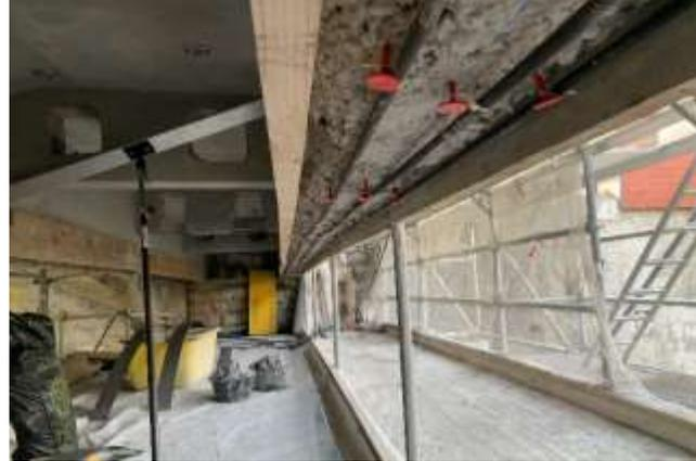
Posizionamento e fissaggio dell'armatura re-bar
