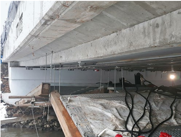
Poutres en acier existantes avec revêtement anticorrosion
