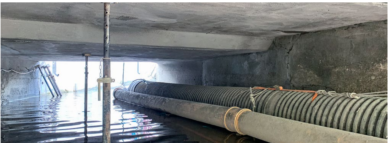
Passage après le renforcement
