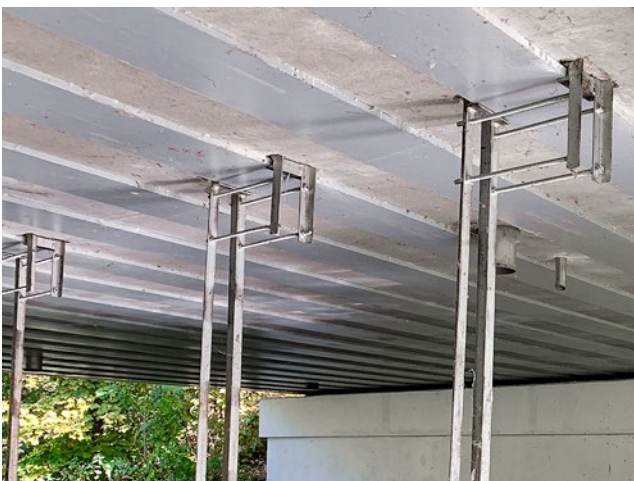
Poutres en acier existantes avec revêtement anticorrosion
