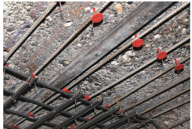
Fixation de re-bar à l'armature interne (avec re-clip) et au support porteur (avec re-bolt)
