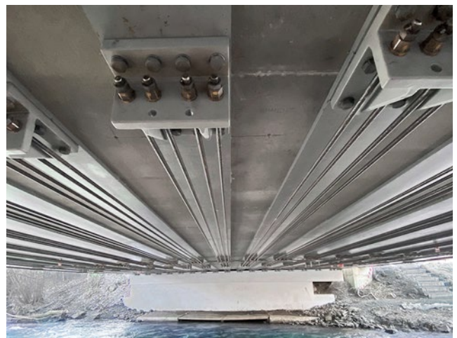
Installation des re-bar R18 avec ancrages d'extrémité
