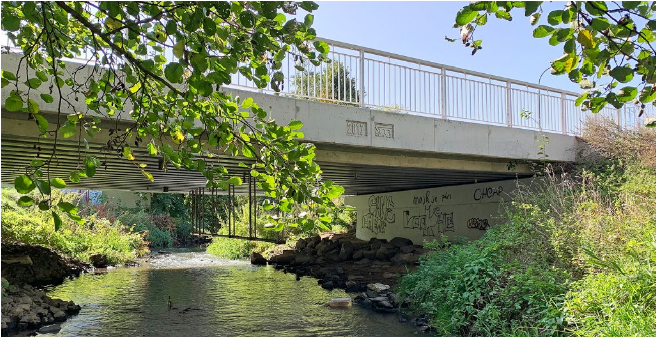
Pont composite acier-béton avant renforcement
