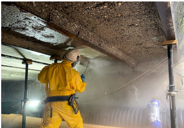
Après l'enlèvement de la paroi intermédiaire, du support provisoire et de la rugosité réalisée de manière hydromécanique
