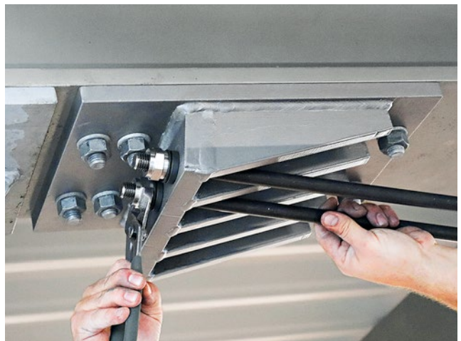
Boulonnage de l'ancrage d'extrémité
