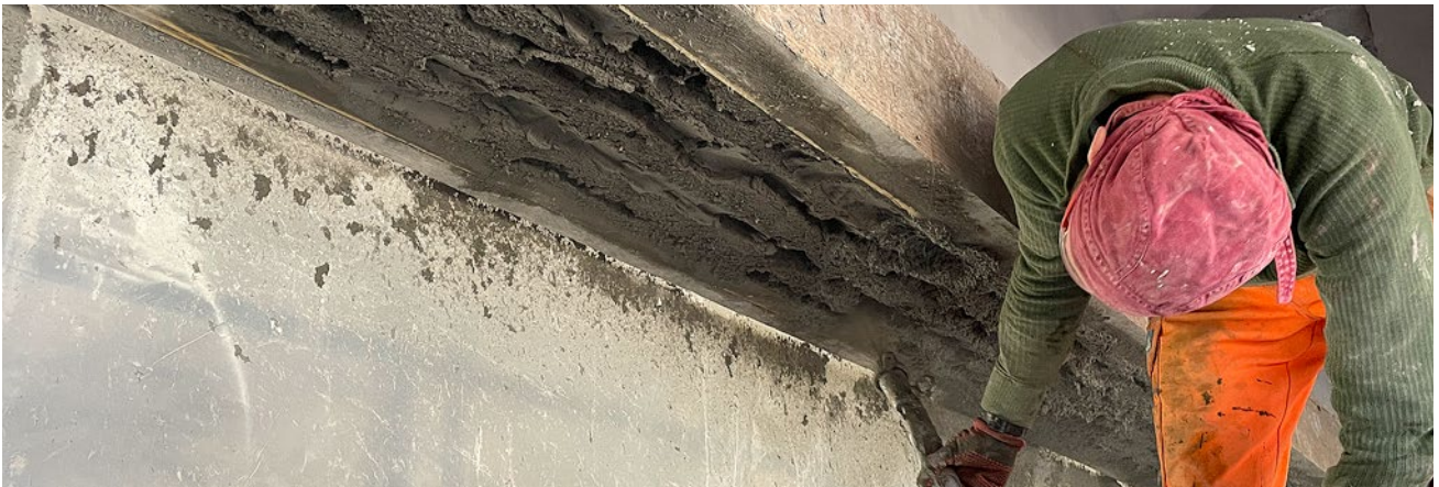
Scellement des re-bar avec du mortier projeté Sika
