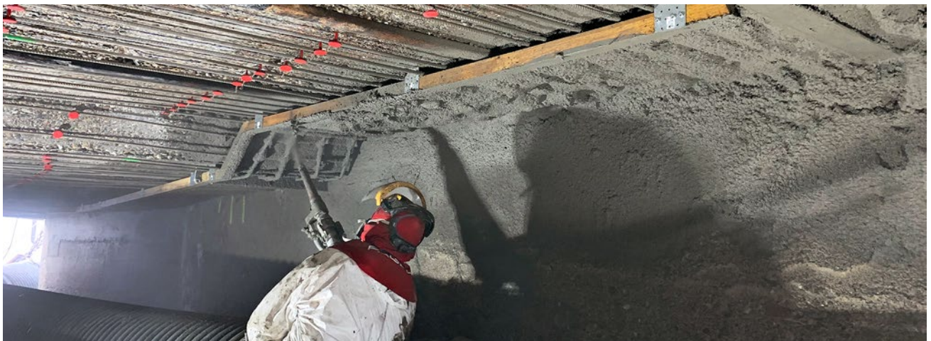
Ancrage d'extrémité sur les deux côtés de 600 mm des barres re-bar avec mortier projeté par voie humide Sika MonoTop®
