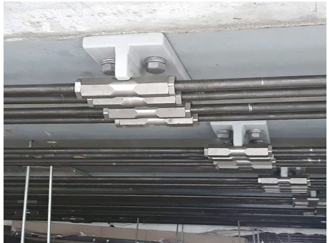
Appuis au centre des poutres en acier
