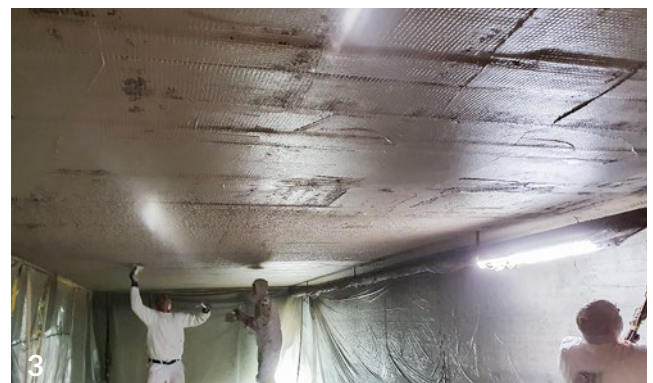
3 Protection ignifuge pour re-plate en combinaison avec les lamelles en PRFC
