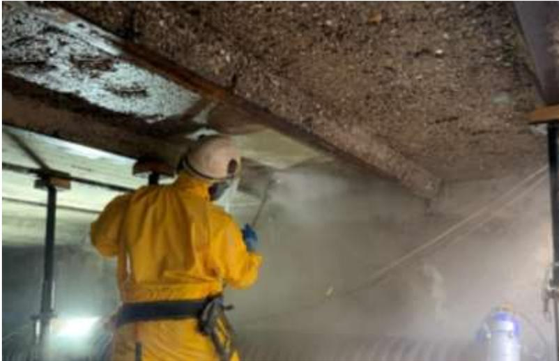
Hydromechanisch abtragen des Betons
