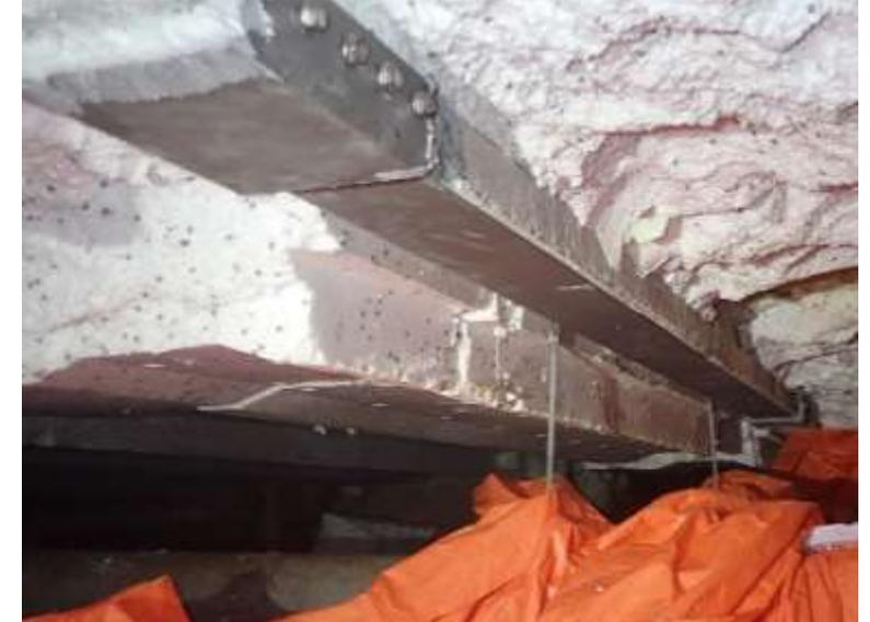
Ancrages avec soudures
