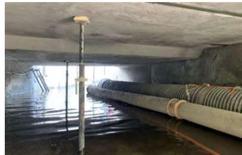
Attivazione delle re-bar, applicazione della malta a spruzzo tra le zone di ancoraggio e riprofilatura
