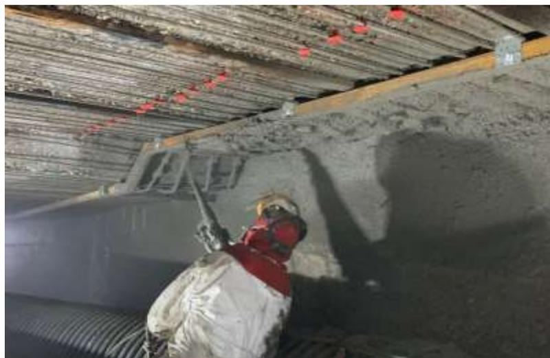
Fissaggio delle re-bar e realizzazione dell' ancoraggio con malta a spruzzo
