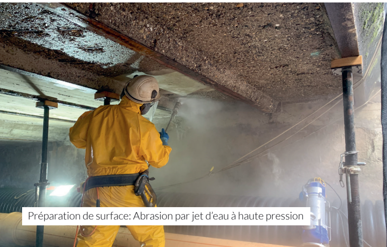
Renforcement en flexion d'une dalle de pont
