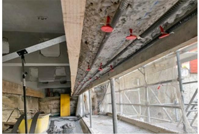
Area di ancoraggio di tre re-bar 16 (precompressi) con tre staffe a U Ø12 in acciaio strutturale in malta spruzzata Sika
