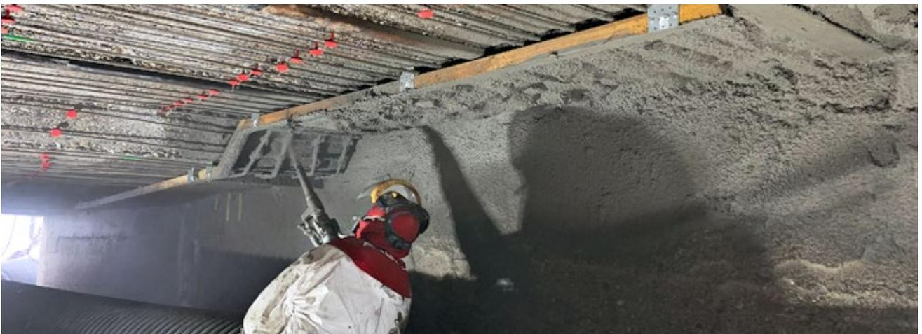
Ancoraggio terminale su 600 mm dei tondini re-bar con la malta spruzzata a umido Sika MonoTop®.
