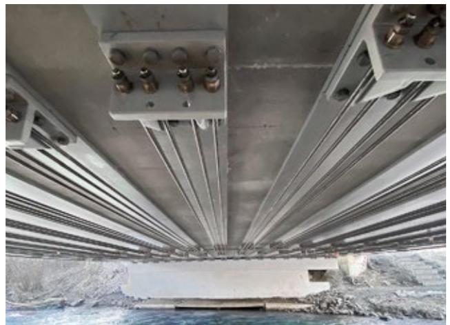
re-bar R18 montato con gli ancoraggi terminali
