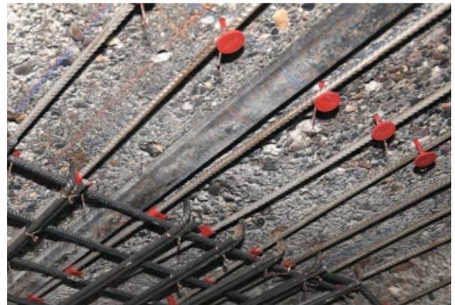
Fissaggio dei re-bar all'armatura interna (re-clip) e alla base portante (re-bolt).
