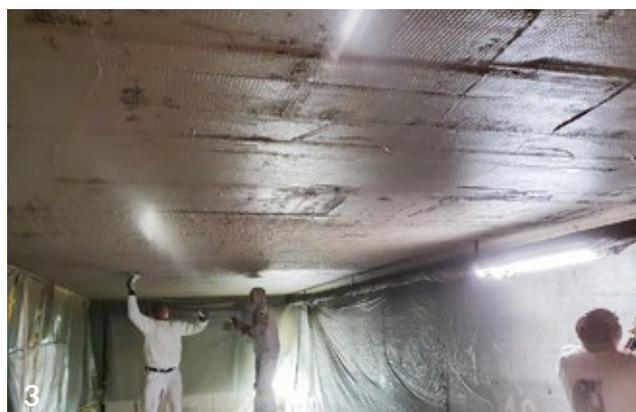
3 Protezione antincendio per re-plate in combinazione con lamine in CFRP
