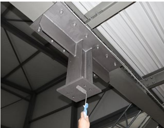
Collegamento del supporto di deflessione R18 e applicazione della protezione antincendio
