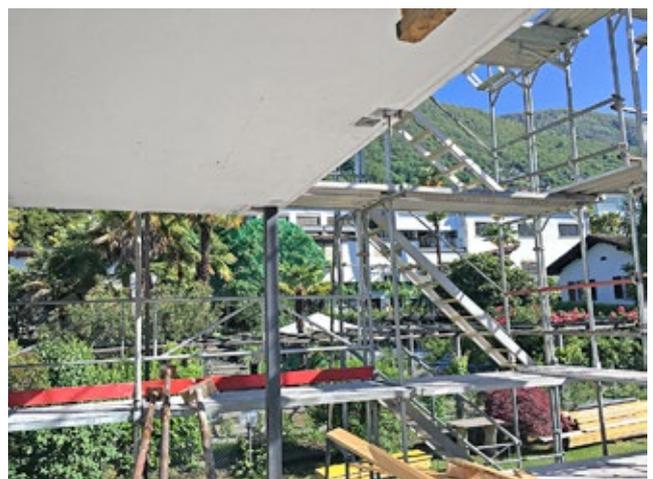
Sulla superficie superiore di un balcone sopra un appoggio esterno esistente, si aumenta il momento negativo così da poter rimuovere un altro appoggio esterno sottostante.
