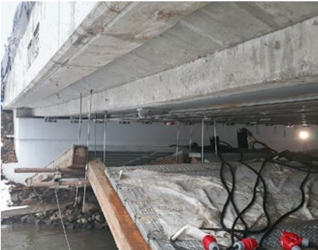
Travi in acciaio esistenti con rivestimento anticorrosione
