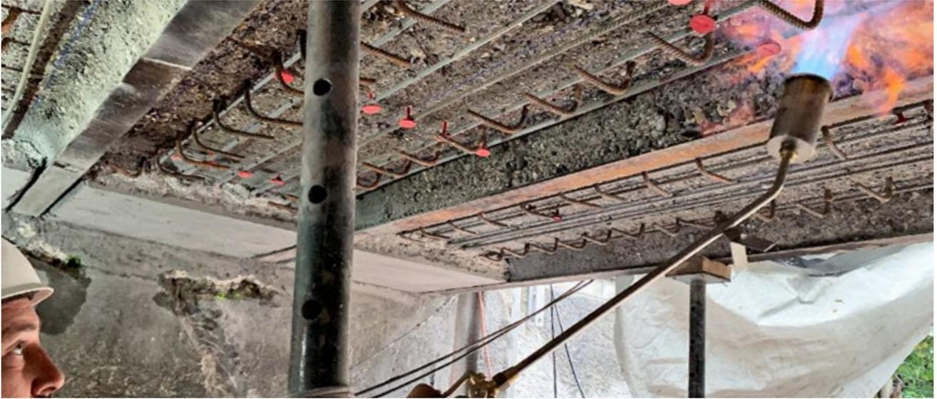
Attivazione dei re-bar con fiamma a gas e controllo della temperatura
