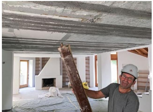
Mettendo in sovracompressione un giunto di dilatazione e rimuovendo il pilastro sottostante, la luce dell'asse di trazione principale aumenta. re-plate garantisce l'aumento del momento flettente positivo e la sovracompressione del giunto.
