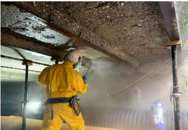
Dopo la rimozione della parete intermedia, supporto temporaneo e irruvidimento idromeccanico.
