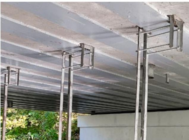
Travi in acciaio esistenti con rivestimento anticorrosione
